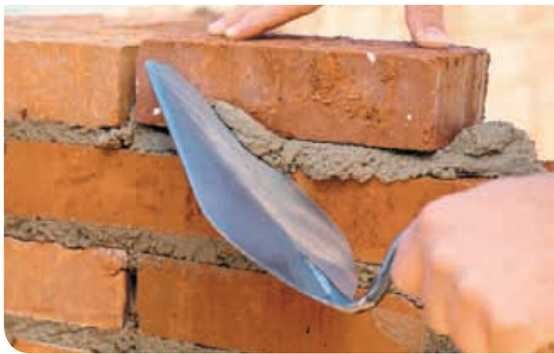
Aplicando argamassa | Spreading mortar | Aplicación de mezcla
