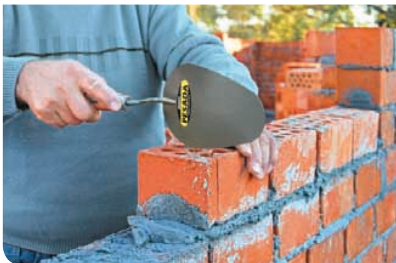
Assentando tijolos | Leveling bricks | Asentamiento de ladrillos
